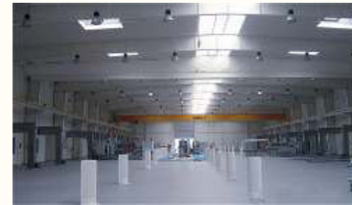
конструкция с кран-балкой
